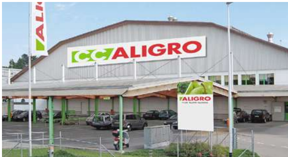
CC ALIGRO, Brüttsellen Generalrevision und Umbau
