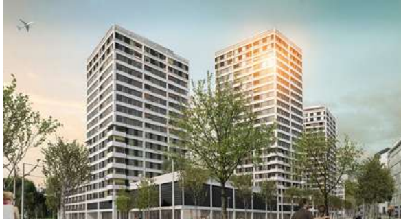
MESSETURM, Zürich-Oerlikon Neubau mit Bauseits Partner AG
