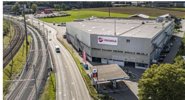
TRANSGOURMET/PRODEGA, Moosseedorf Generalrevision und Sanierung
