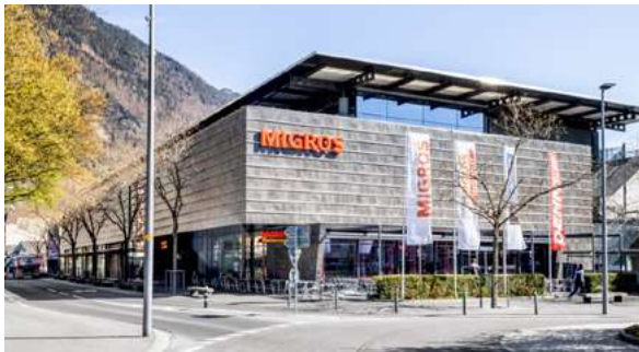
MIGROS (GMAA), Interlaken Generalrevision und Sanierung
