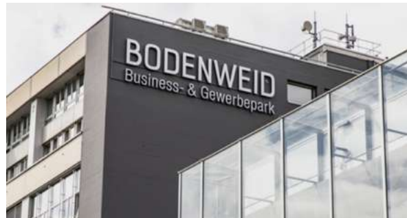
BUSINESS & GEWERBEPARK BODENWEID, Bern Neubau
