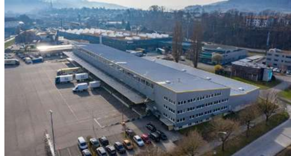
CAMION TRANSPORT AG, Burgdorf Anbau und Umbau
